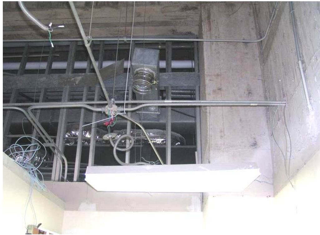
天花板拆除作業現場
