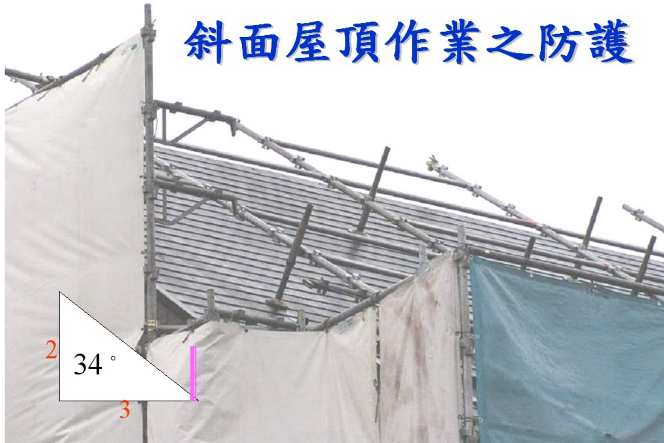
日本斜面屋頂作業用施工架
