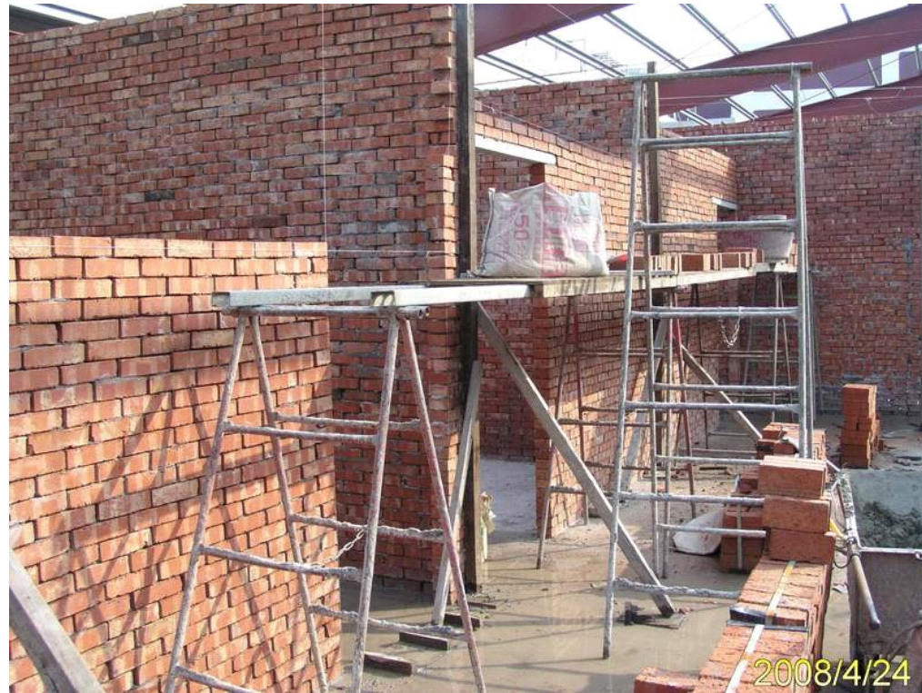
廠房增建宿舍之新砌磚牆
