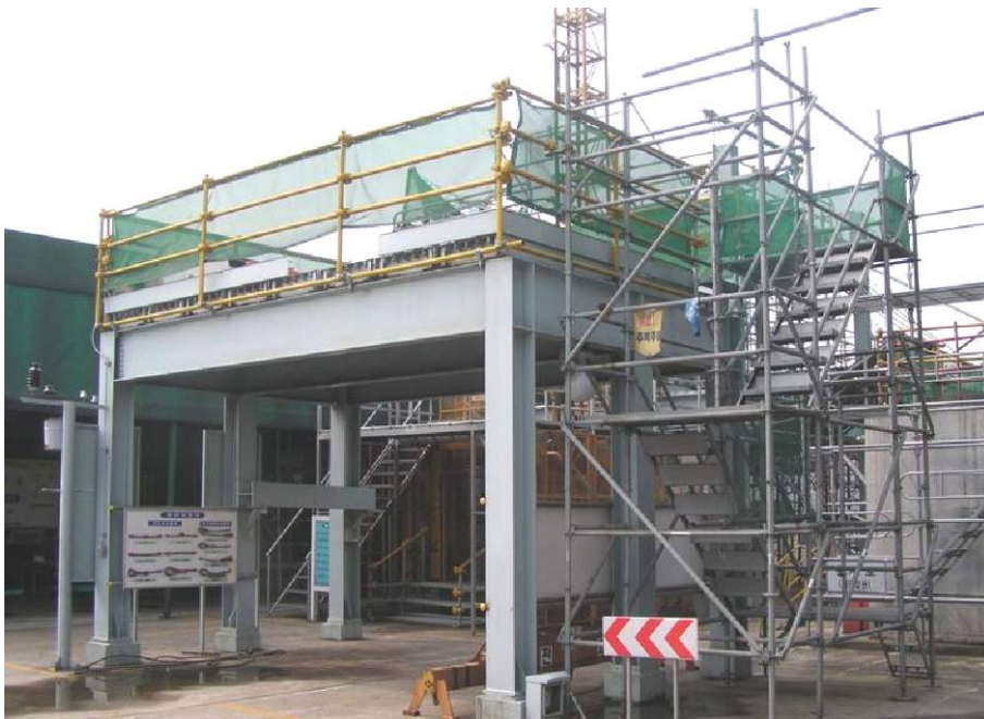
提供攀登屋頂之內爬梯式施工架
