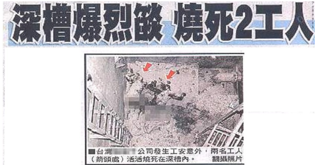
深槽防水塗裝作業發生爆燃災害
