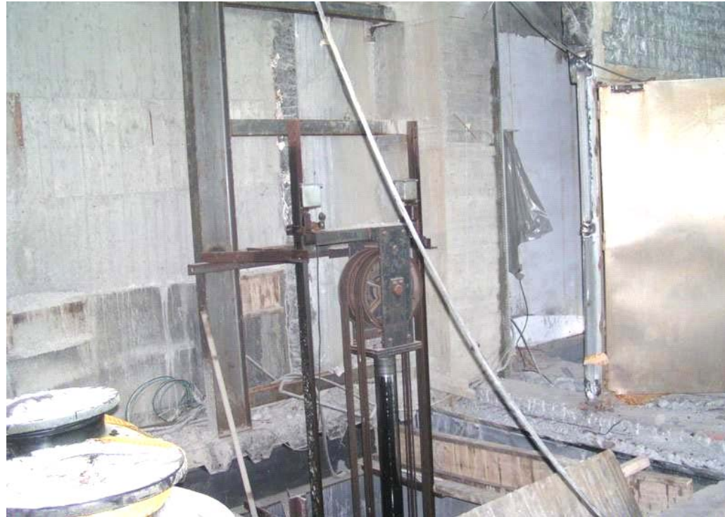
廠房內載貨梯延升工程施工現場
