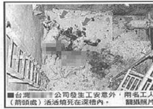
深槽防水塗裝作業發生爆燃災害
