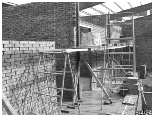
廠房增建宿舍之新砌磚牆
