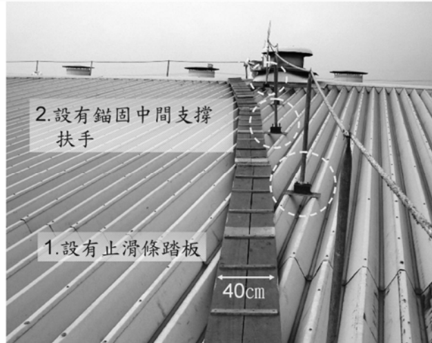
廠房屋頂維修設置階梯、水平安全母索
