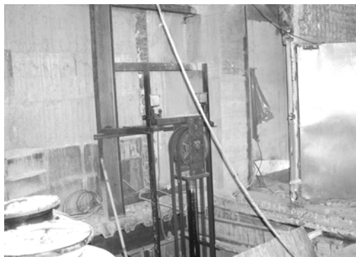
廠房內載貨梯延升工程施工現場
