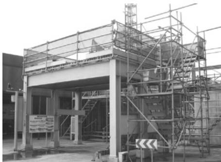
提供攀登屋頂之內爬梯式施工架
