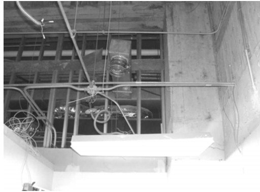
天花板拆除作業現場
