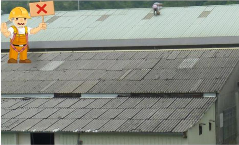
圖 40·於易踏穿材料構築及具傾斜面之屋頂作業時，未先規劃安全通道。
