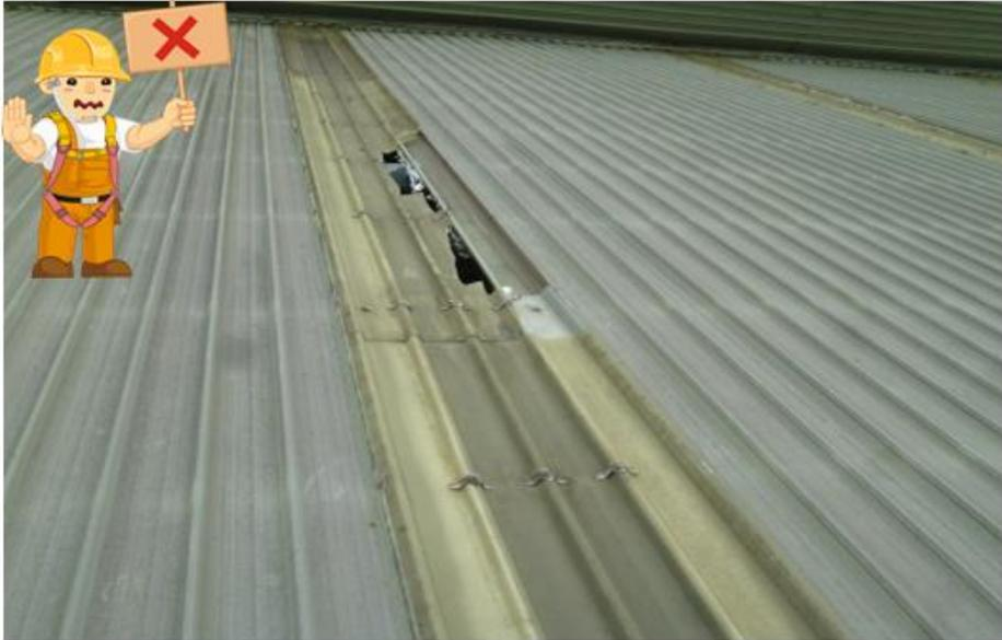
圖 38 於易踏穿材料構築之屋頂作業時，事先未規劃安全通道。
