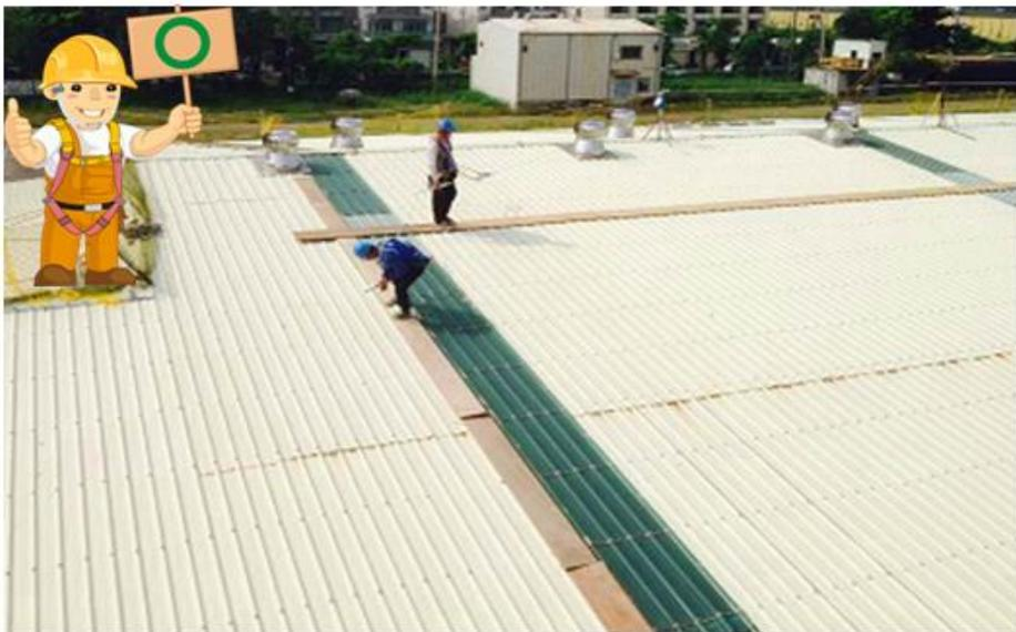
圖 39 設置之安全通道依規定設置適當強度、寬度 30 公分以上之踏板。
