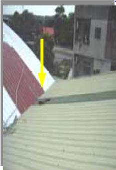
從事屋頂油漆作業，未配戴合格防護具，踏穿塑膠採光罩，從屋頂墜落，經送醫不治死亡。
