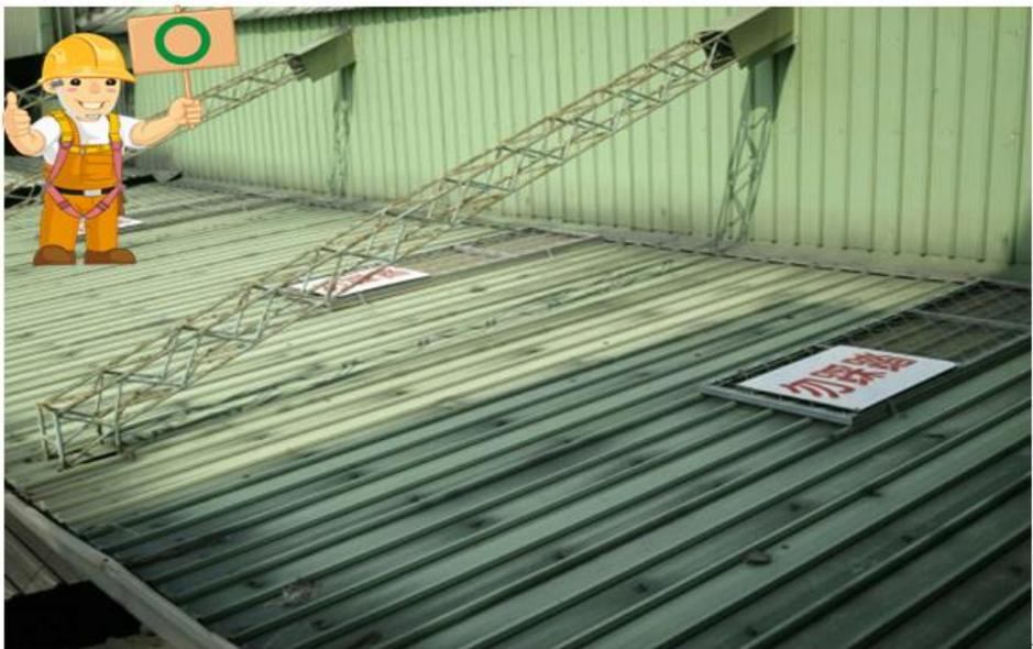
圖 43 易踏穿材質屋頂板，應設置格柵板，並標示勿踩踏警示標語。
