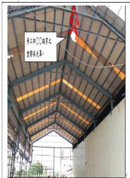
說明 照片二：勞工許○○踏穿之採光罩(塑膠材質)屋架上未有適當強度，且寬度在三十公分以上之踏板或裝設安全護欄。
