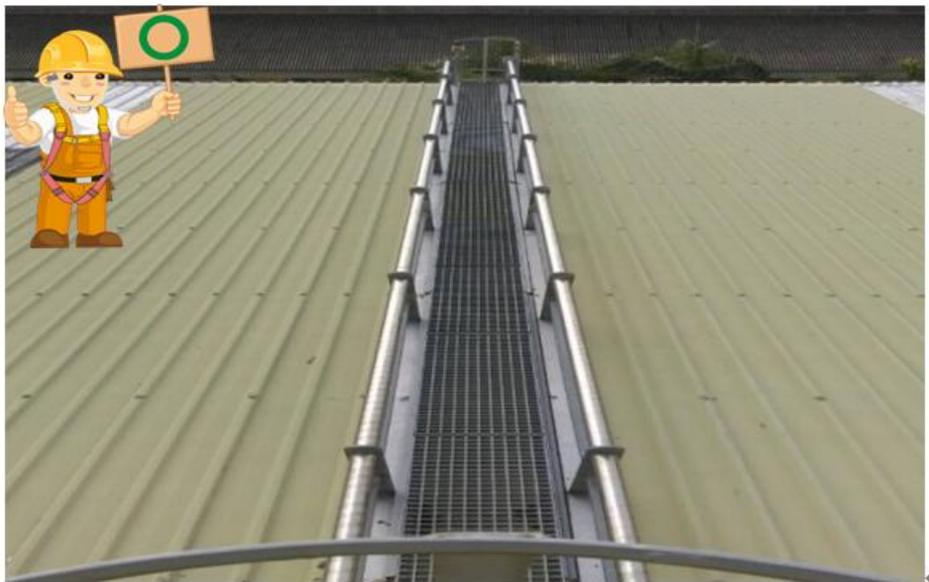
圖 41·使用格柵板做為安全通道，並設置扶手防止墜落、滾落及滑倒。
