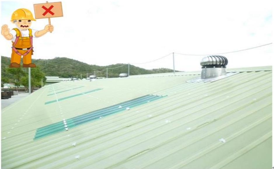
圖 42 人員欲進行易踏穿材質(塑膠)屋頂板作業時，未設置防止人員踏穿墜落之安全防護措施。
