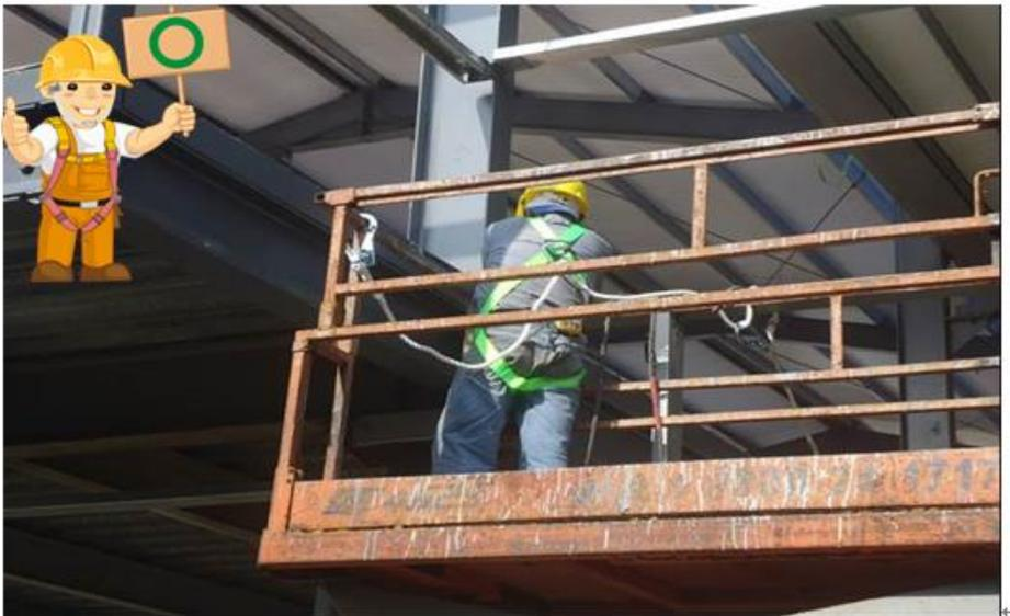
圖 37·於高空工作車之工作台內實施作業，並確實佩戴安全帶及鈎掛堅固物件上。
