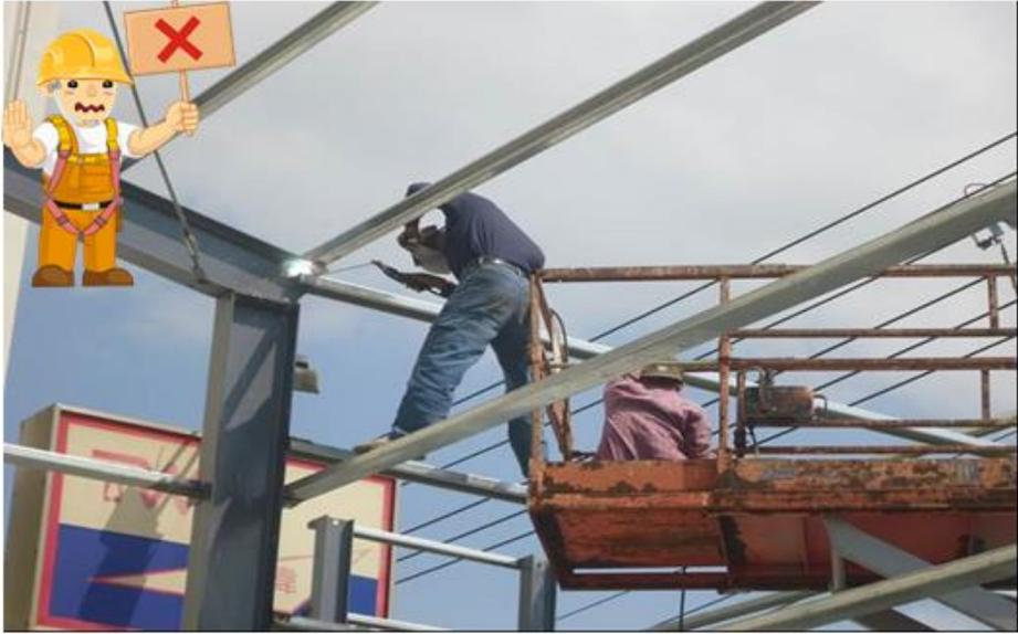
圖 36·勞工未於高空工作車之工作台內實施作業，且未佩戴安全帶。
