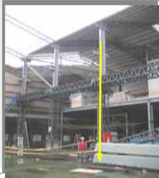
從事屋頂中直板烤漆浪板安裝作業，未確實配戴防護具於斜屋頂行進時不慎沿斜屋頂滑落，並由屋簷邊緣開口墜落至地面上，經送醫急救，不治死亡。
