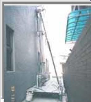
從事遮雨棚安裝作業，欲下移動梯時，突然踩空並向下墜落於隔棟建築物外牆與一樓頂既有之遮雨棚夾縫間，於送醫途中即不治死亡。
