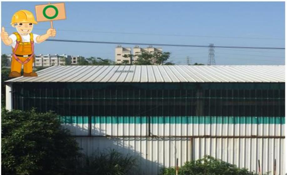
圖 35. 將採光罩設置於側牆，將原採光罩位置以彩色鋼板鋪蓋，減少人員墜落風險。
