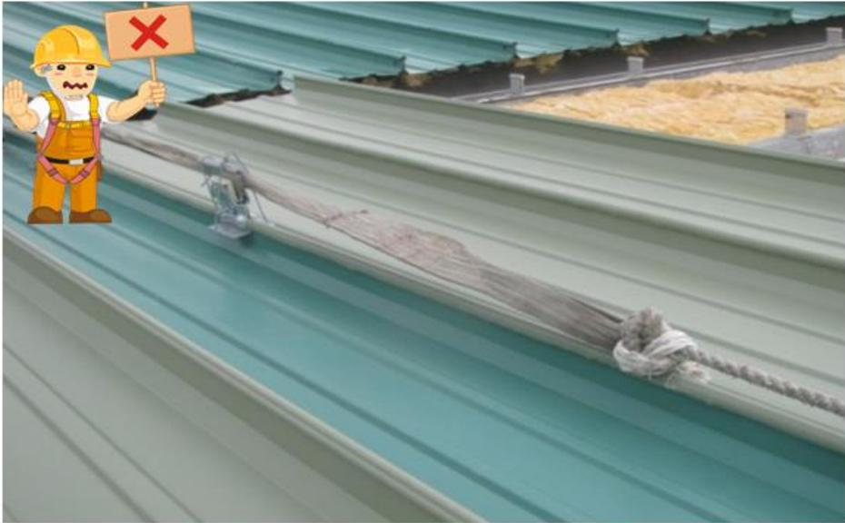
圖 44 設置之安全母索應為鋼索、尼龍繩索或合成纖維之材質，並不得使用綁紮方式進行連接。
