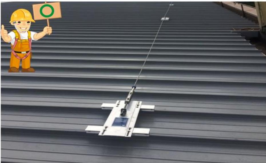
圖 45 (水平)安全母索以鋼索材質設置，其最小斷裂強度應在 2,300 公斤以上。
