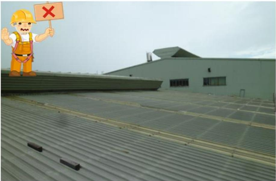
圖 34·塑膠採光罩經日曬雨淋及積塵已不易辨識位置，人員於屋頂作業時容易誤踩踏穿，致由該處墜落。
