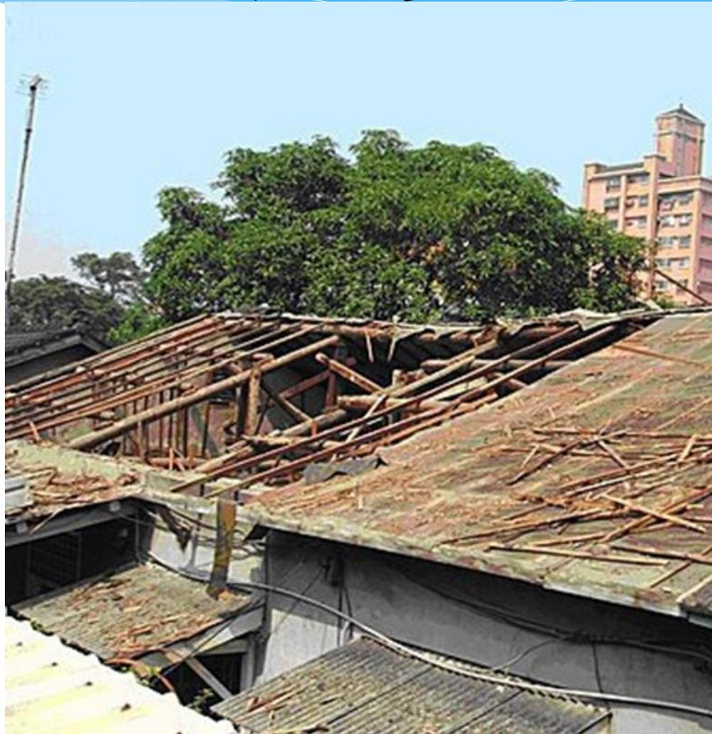
拆除瓦片、掛瓦條、底板、油毛氈
