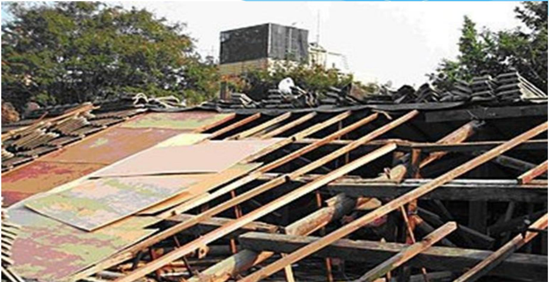
更換、補強桁條、椽木、簷板、釘底板、天花板拉水平
