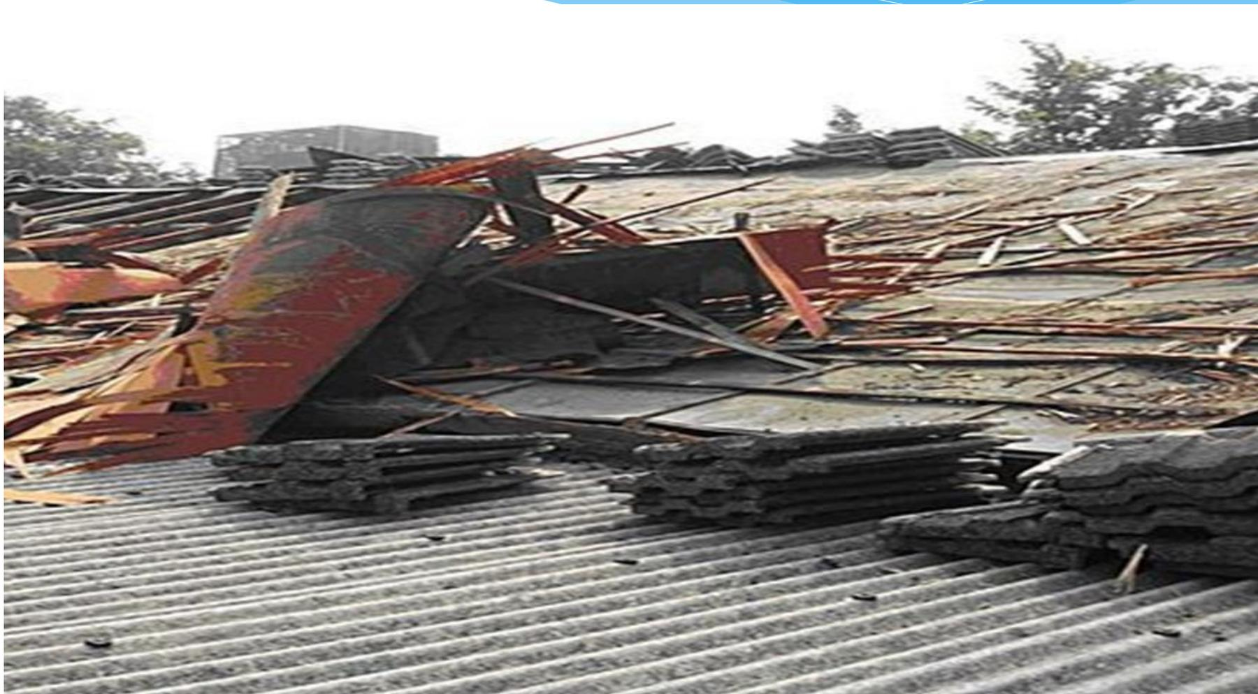
拆除瓦片、掛瓦條、底板、油毛氈
