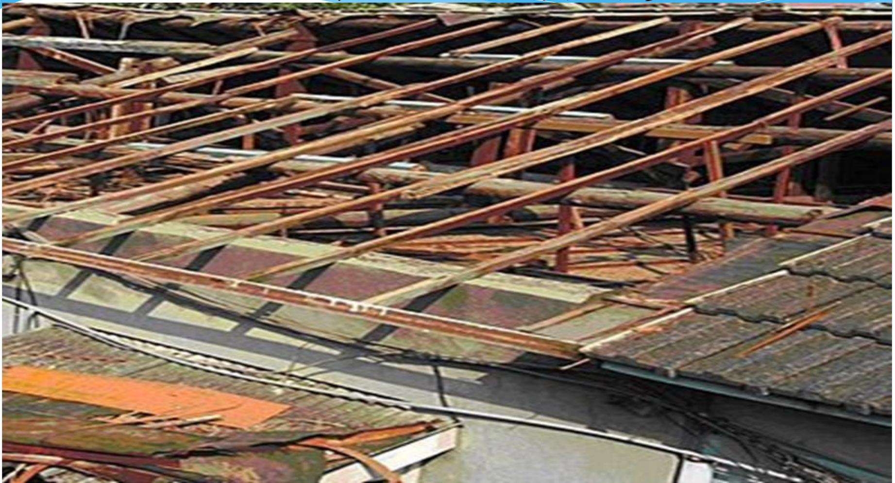
更換、補強桁條、椽木、簷板
