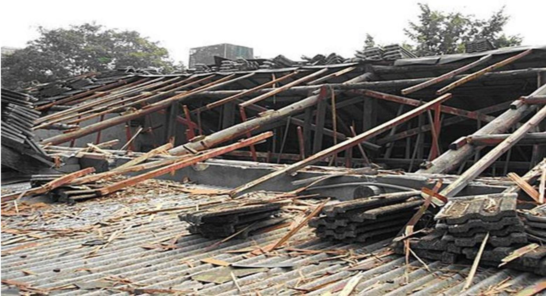
屋頂底板拆除後的狀況
