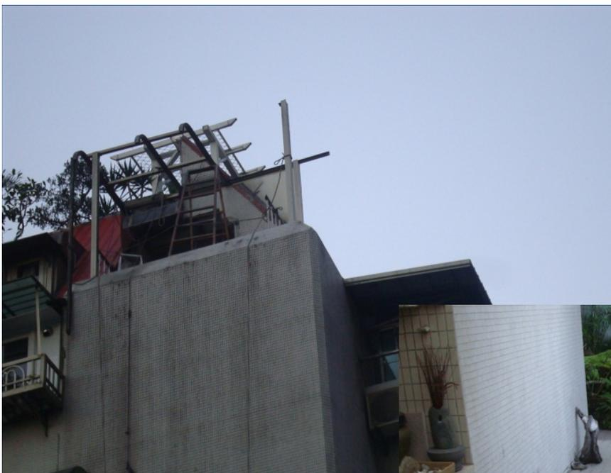
勞工站於露臺之鐵合梯上進行舊採光罩骨架拆除作業。
