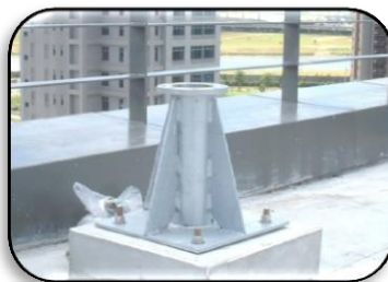
L型吊臂固定基座(座地式)
