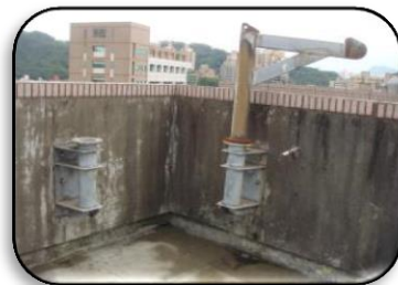
L型吊臂固定基座(扶壁式)
