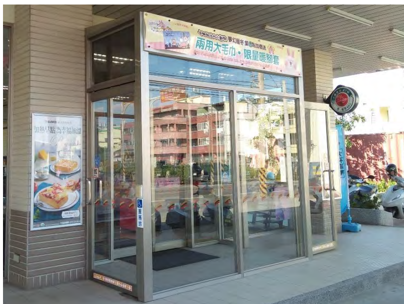
圖 5-4 便利商店出入口除風室
