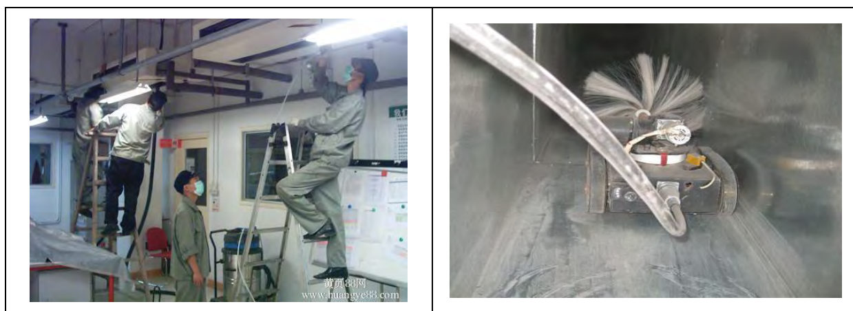
圖 5-10 以人工與機器人清潔風管
