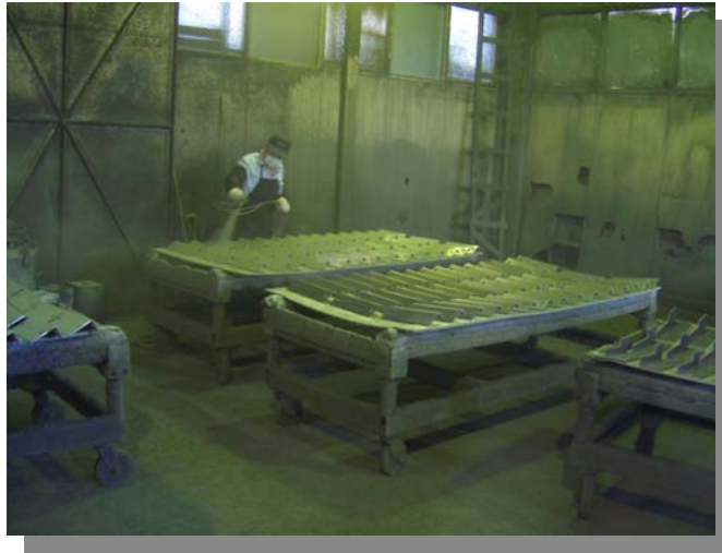
圖2.9 噴塗作業之人員未佩戴正確之呼吸防護具
