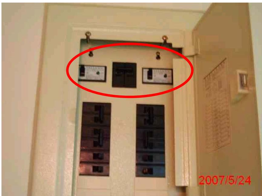
圖 7.7 作業現場如為潮濕場所其設備電路上設置漏電斷路器
