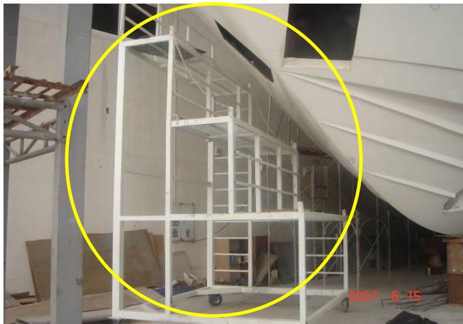
圖 6.11 設有護欄之階梯式工作台
