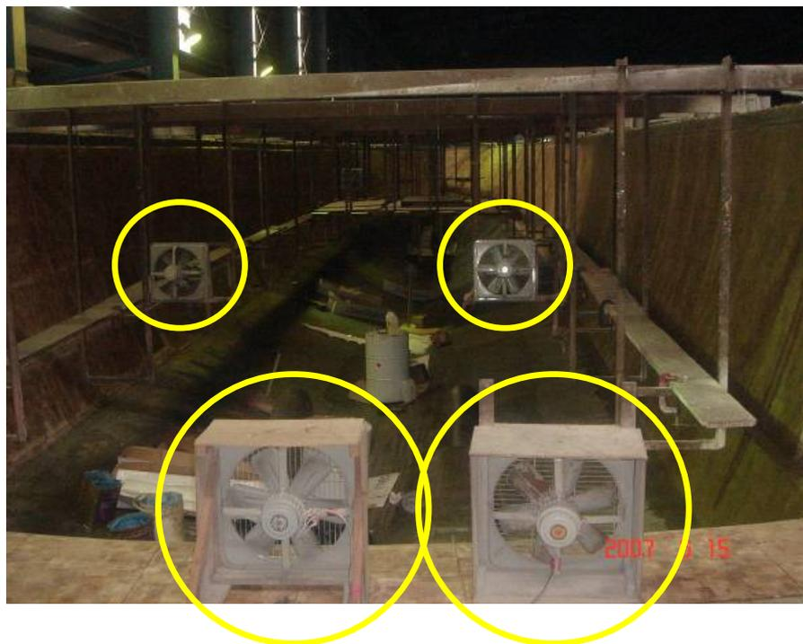
圖 6.9 船殼積層施工設置排氣設施
