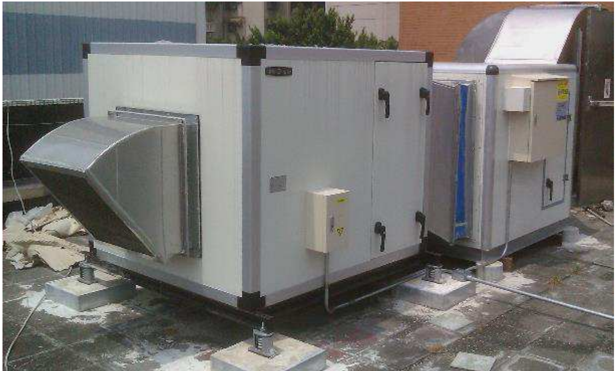
圖3 AHU系統之空調箱
