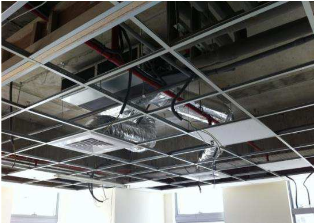
圖5 FCU空調系統之送風機通常位於天花板內
