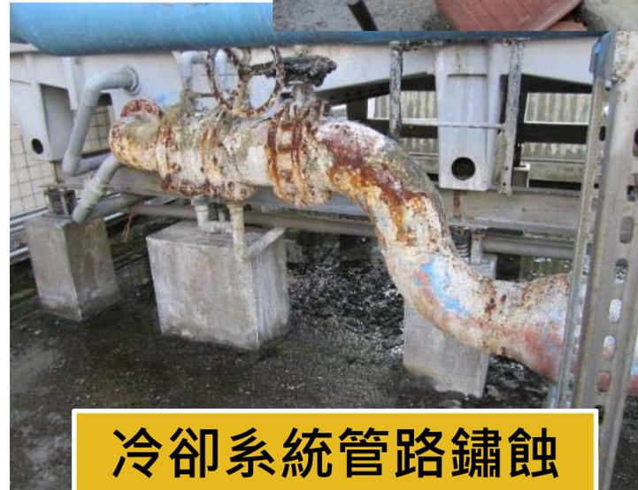
冷卻系統管路鏽蝕
