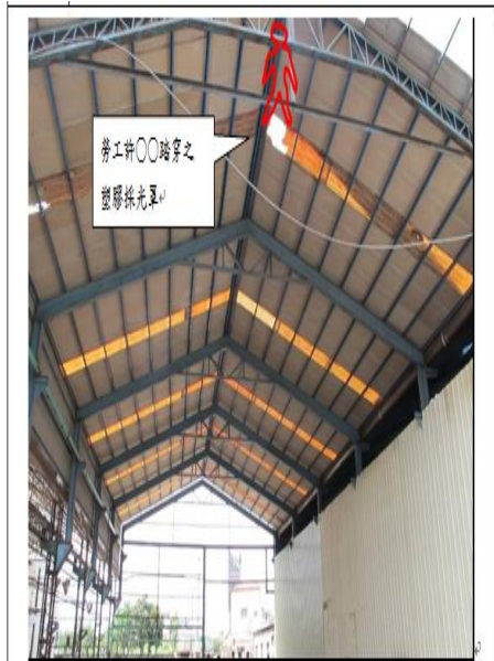
說明* 照片二：勞工許○踏穿之採光罩(塑膠材質)，屋架上未有適當強度，且寬度在三十公分以上之地板或裝設安全護欄。
